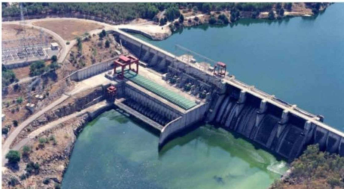
Presa de Azután en el río Tago (Toledo)
