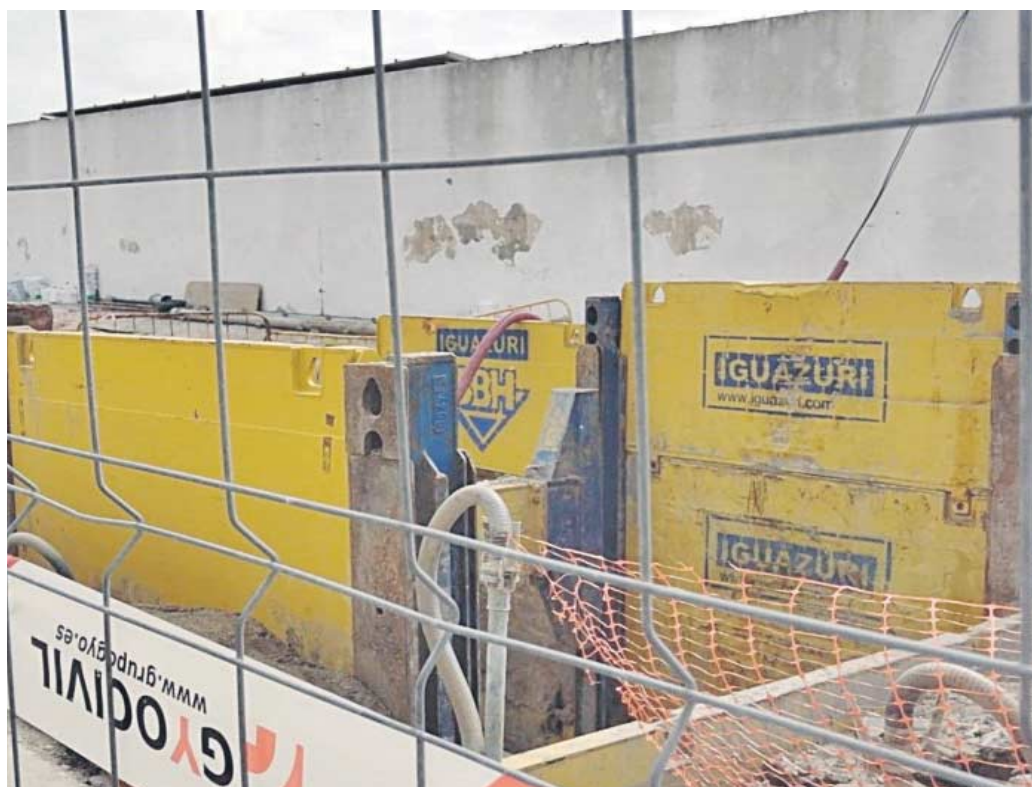
Máquinas en las obras del tanque de tormentas, en la avenida de la Bajamar.
