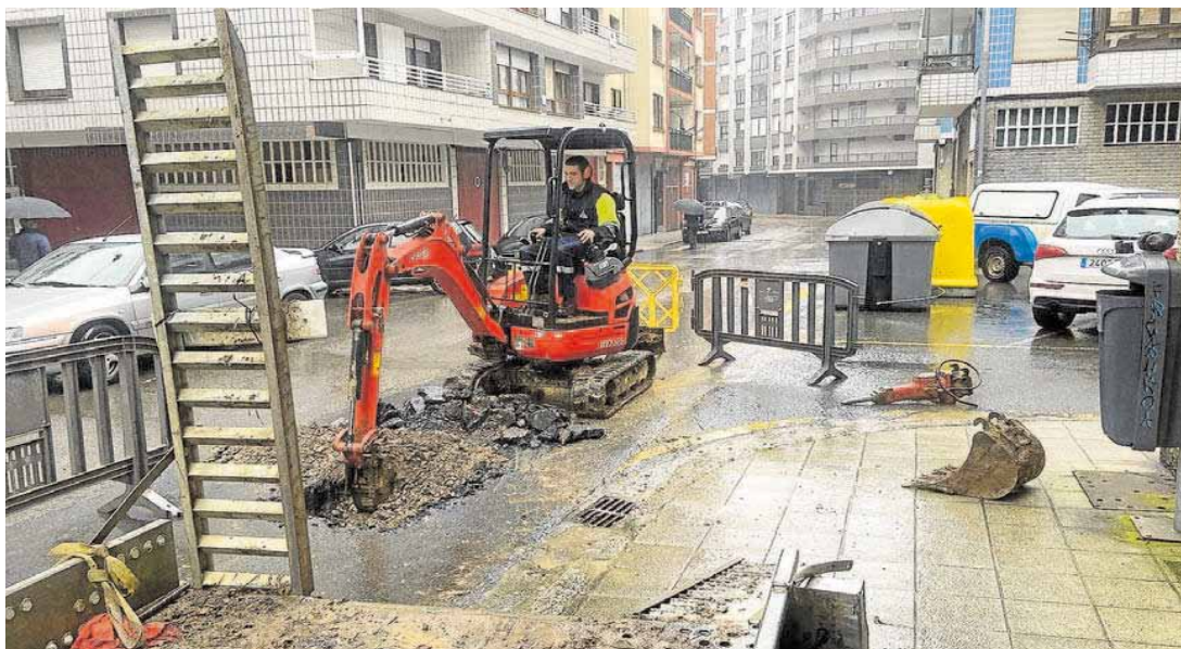
El Consorcio tiene cuatro equipos, uno por zona, para solventar las incidencias y reparar los reventones. CABB
